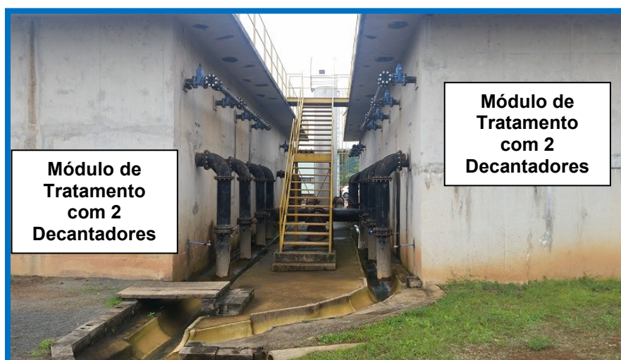
Figura 1 - Vista dos módulos de tratamento e das tubulações de descarga dos Filtros.
